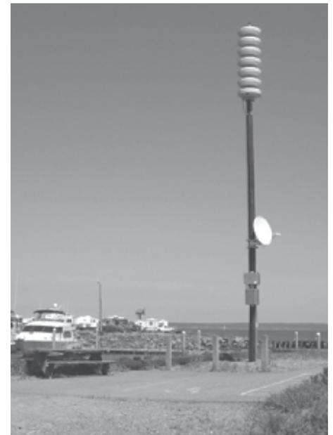
La unidad de "Emisión de Alerta para Todo Tipo de Catástrofes" (AHAB, por sus siglas en inglés) en Point Hudson es una de las tantas sirenas instaladas en los condados de Clallam y Jefferson. Las AHAB pueden activarse mediante satélite desde el Centro de Operaciones de Emergencias Estatal o mediante radio desde los Centros de Operaciones de Emergencias locales.
